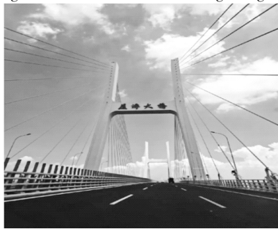
图2 厦漳大桥桥面图
