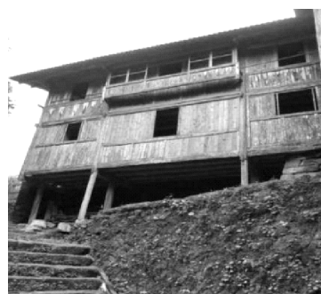
图4 山地吊脚楼民居的杉木板墙体
