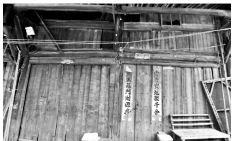
图6 建筑主体全由杉木建造的临街民居
