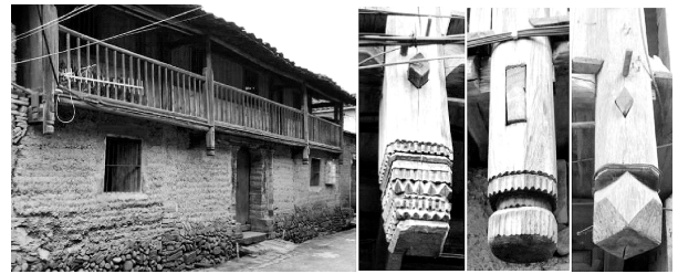
图 14 武夷民居檐部下方的挑廊吊柱
