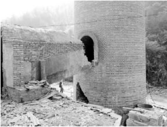
图 2 排烟道拆除前
