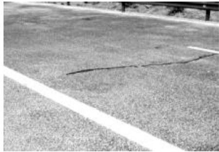
图 3 表面裂缝
